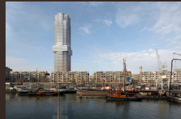
Cooltower Rotterdam - Ramen
